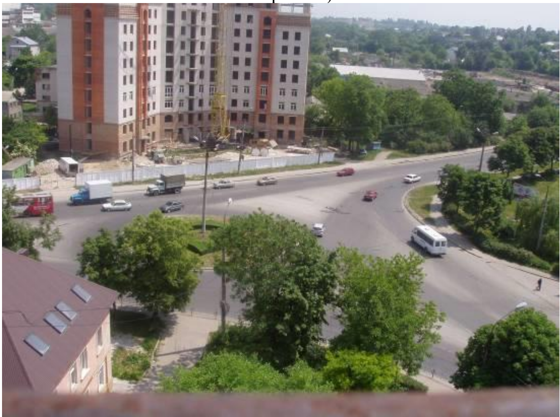
Транспортна розв'язка вулиць Микулинецька, Живова, Острозького, Замонастирська, Гайова у м. Тернопіль (стаціонарний пост спостереження за станом атмосферного повітря № 2)
